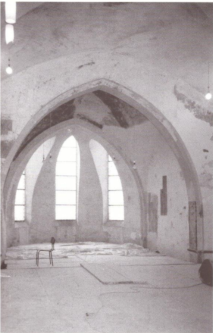
Rekonstruktion und Schlussstein im Gewölbe (linke und rechte Abbildungen)
